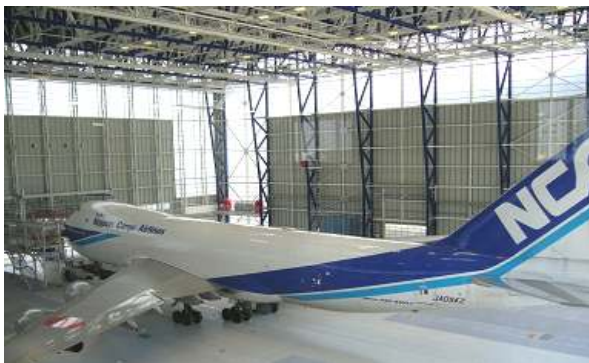
格納庫内部:間接光による均質な自然光
