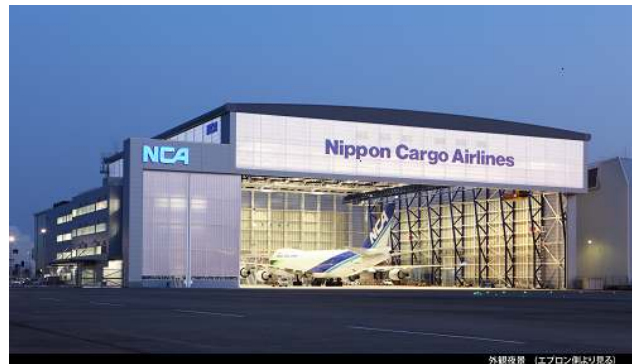
格納庫全景:エプロン側からの夕景
