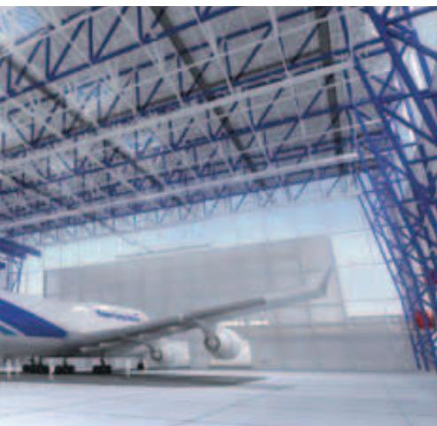
NCAが建設を進めているエコハンガーの完成予想図。壁面や大扉に断熱性の高い半透明の複合材を多用。日中の整備作業に照明は必要なく、また通風性にも優れているために空調の負担も小さく抑えられている。Image: NCA
